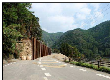
道路の応急復旧
