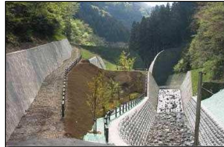
不動谷川砂防堰堤
