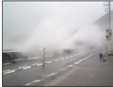
台風第12号による越波 (国道42号 すさみ町口和深)
