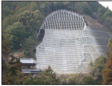
道路法面強化対策 県道たかの金屋線 みなべ町
